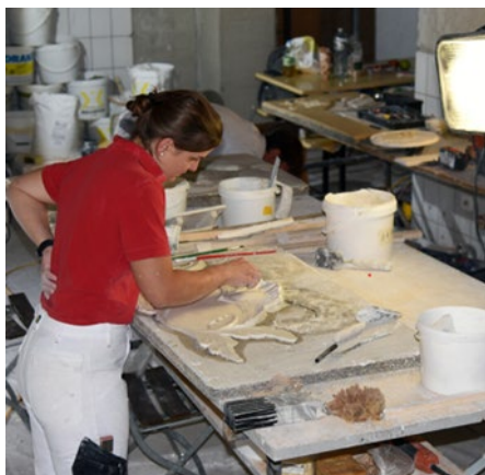
Stuckaturen werden vor Ort neu angefertigt.
