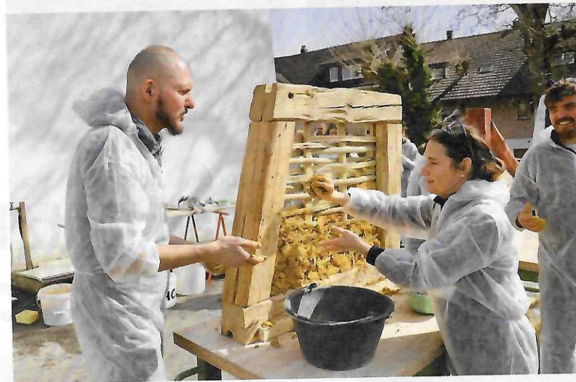
Hand anlegen für den Aufbau einer Lehmwand.
